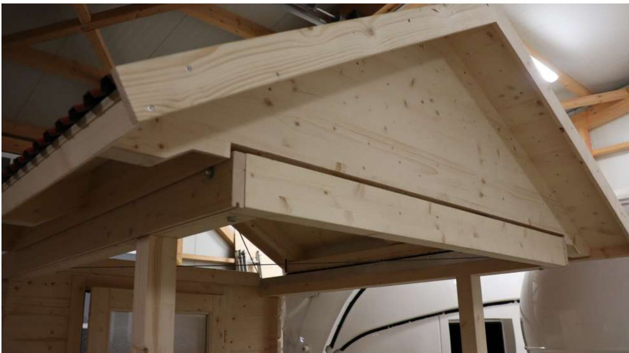
Detail: Ortgang- und Traufbretter, optionale Trapezplatten als Abdeckung.
