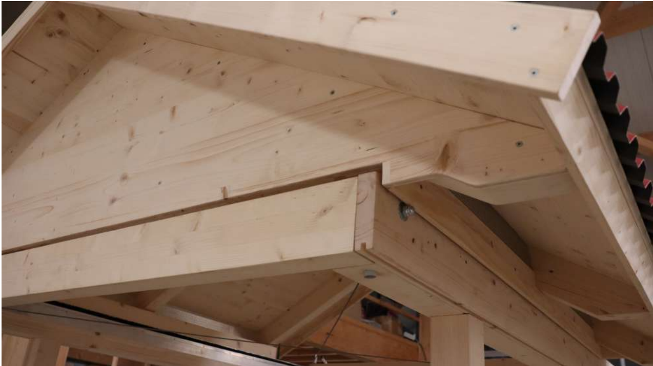
Detail: Ortgang- und Traufbretter, optionale Trapezplatten als Abdeckung.
